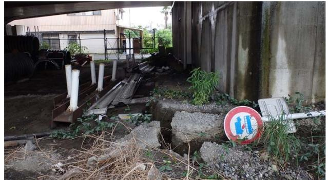
堤内側に位置する橋脚周辺地盤の沈下
