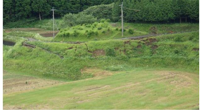
表層の植生の影響 (?) による斜面崩壊時のブロック化
