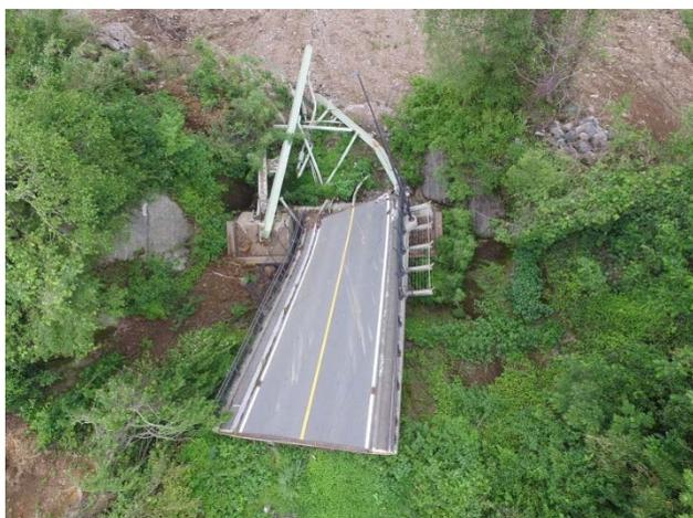
東海大学側（左岸側）に落下した橋桁
