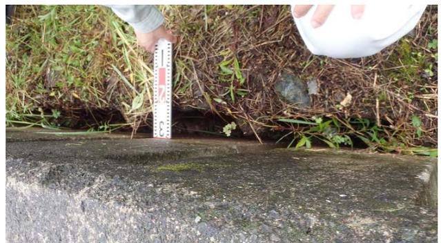
コンクリート擁壁と土間の隙間 (10~15cm)
