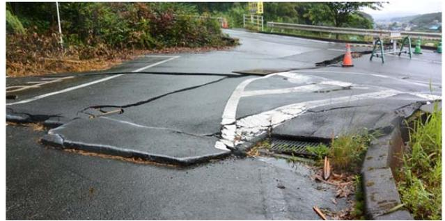
斜面の崩壊に伴い、道路面に生じたクラック
