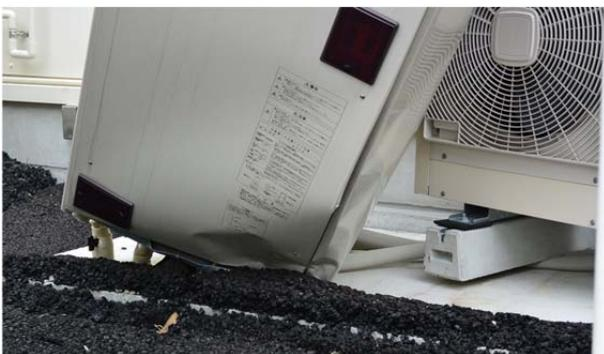
排水パイプの上に室外機が載る (縦方向の振動によるものか)
