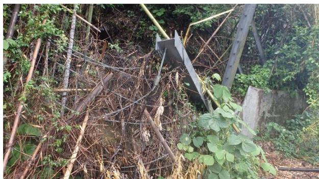
落石防護柵の転倒（落石捕捉）
