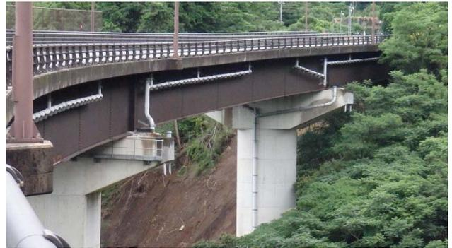
橋桁が支承から落ちるほどの水平方向のずれ（約92cm程度のズレが確認されている）
