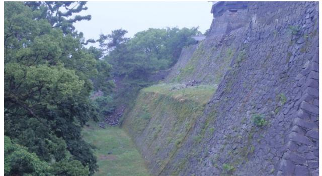
崩壊した石垣は落下高が大きくても斜面法尻や斜面中腹の水平部分で停止しており、崖錐堆積物や表土による運動エネルギー減衰効果が発揮されている
